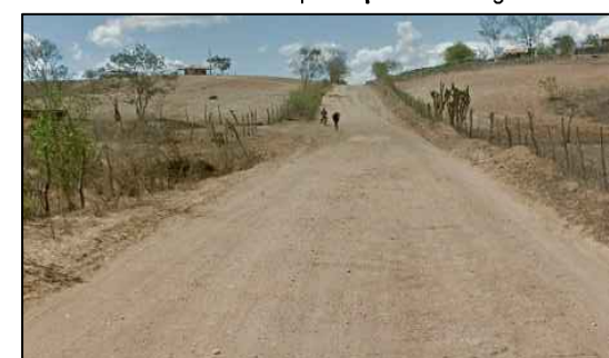
Aterro e/ou Implantação de Drenagem
