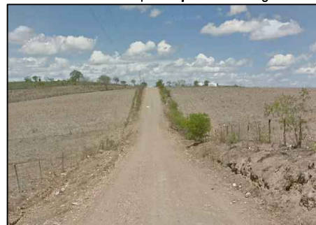
Aterro e/ou Implantação de Drenagem
