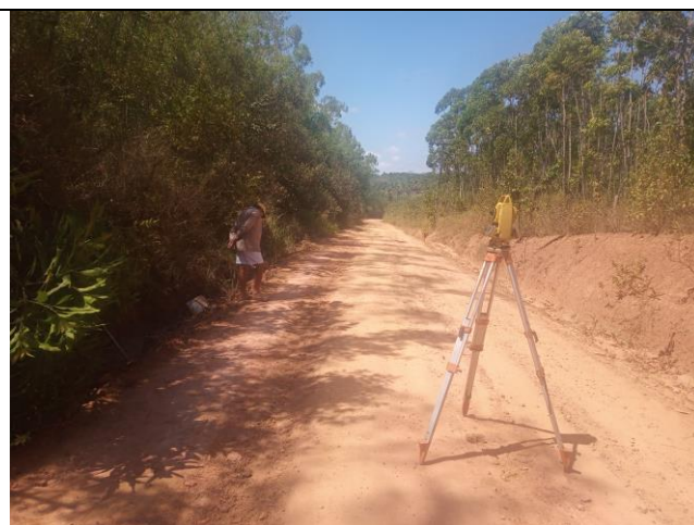
Vista do segmento em revestimento primário
