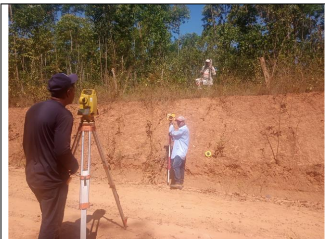
Levantamento das seções transversais
