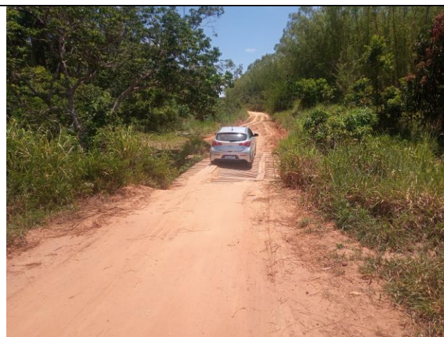
Vista da ponte existente em péssimas condições.
