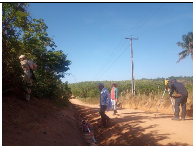
Levantamento das seções transversais
