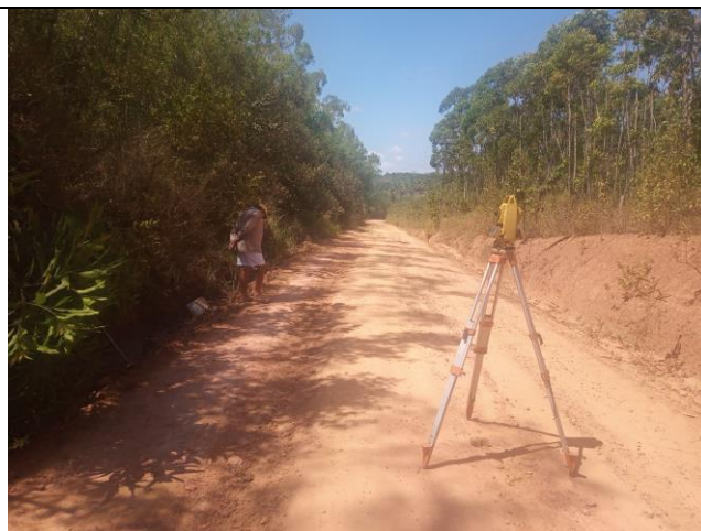
Vista do segmento em revestimento primário
