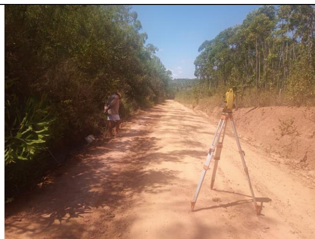
Vista do segmento em revestimento primário
