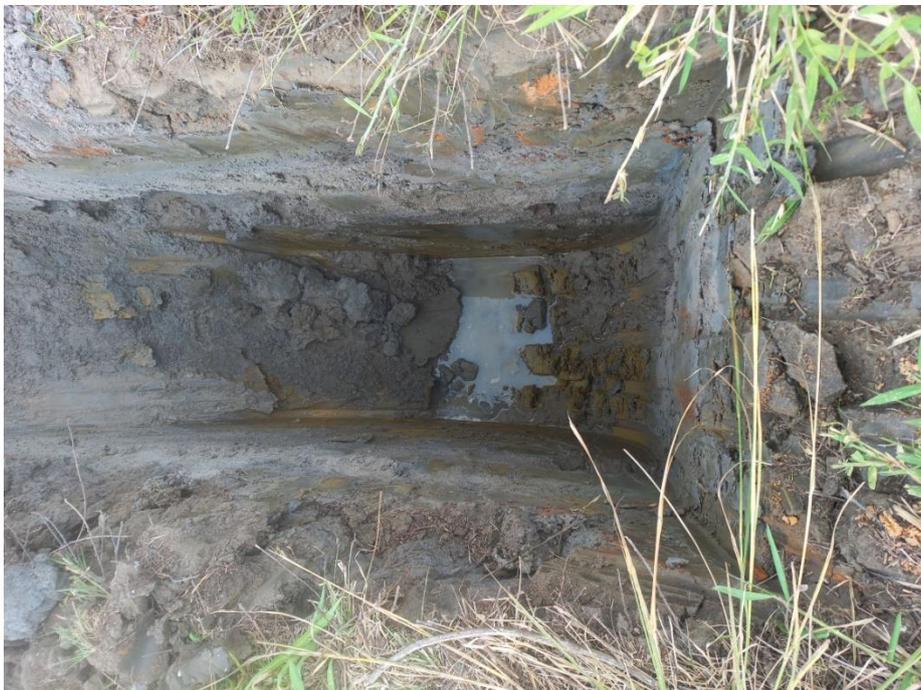
03 EIXO      0,00 a 2,00m      Solo argilo siltoso tipo massapê esverdeado (Saturado), N. A. em 30/01/2023 com 1,60m.
