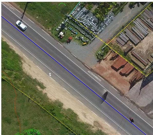
Construção e abrigo de pneus dentro da faixa de domínio. (linha amarela)
