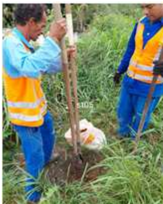
FOTO 05 - Execução do furo ST 05 de Sondagem a Trado.
