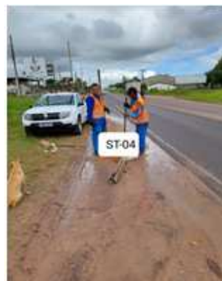
FOTO 04 - Execução do furo ST 04 de Sondagem a Trado.
