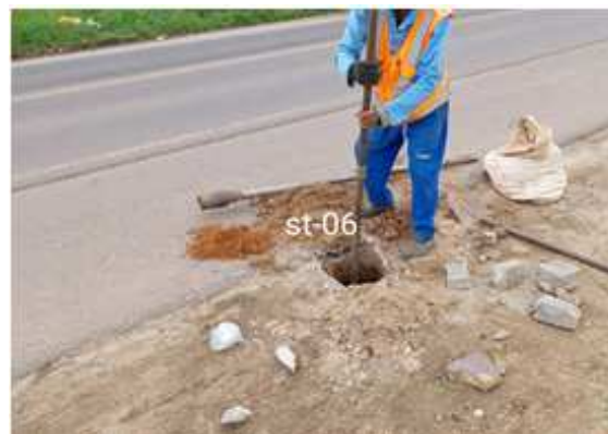
FOTO 06 - Execução do furo ST 06 de Sondagem a Trado.
