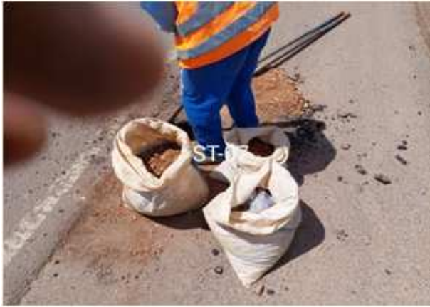
FOTO 07 - Execução do furo ST 07 de Sondagem a Trado.
