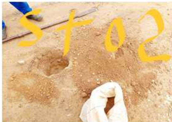
FOTO 02 - Execução do furo ST 02 de Sondagem a Trado.
