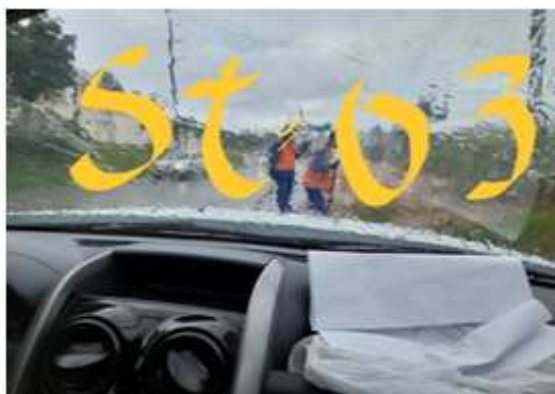
FOTO 03 - Execução do furo ST 03 de Sondagem a Trado.
