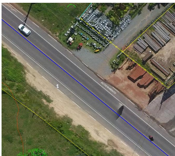
Construção e abrigo de pneus dentro da faixa de domínio. (linha amarela)
