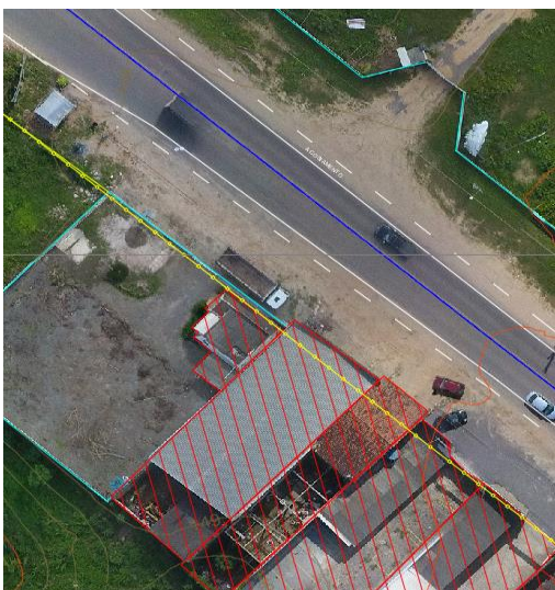
Construção dentro da faixa de domínio. (linha amarela)
